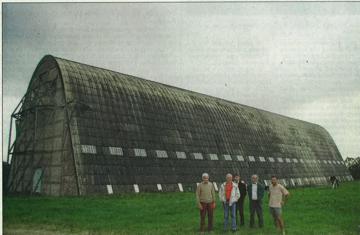
Le hangar à dirigeables d'Ecausseville : 150 mètres de long, 30 mètres de haut, une largeur à la base de 40 mètres. Un bâtiment qui est classé aux Monuments historiques depuis quelques années.
